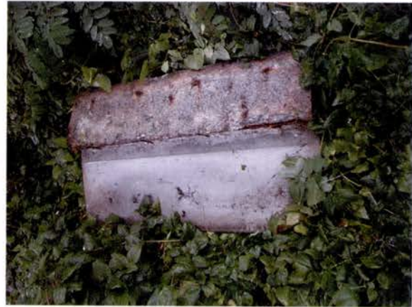
Figure 18 : Chute d'un élément de corniche par rupture de la liaison.
