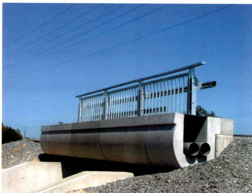
Figure 70. Corniche caniveau avec présence de fourreaux
