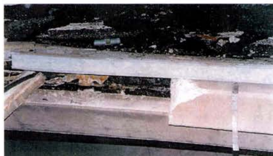
Figure 47. Corniche non liaisonnée au tablier
