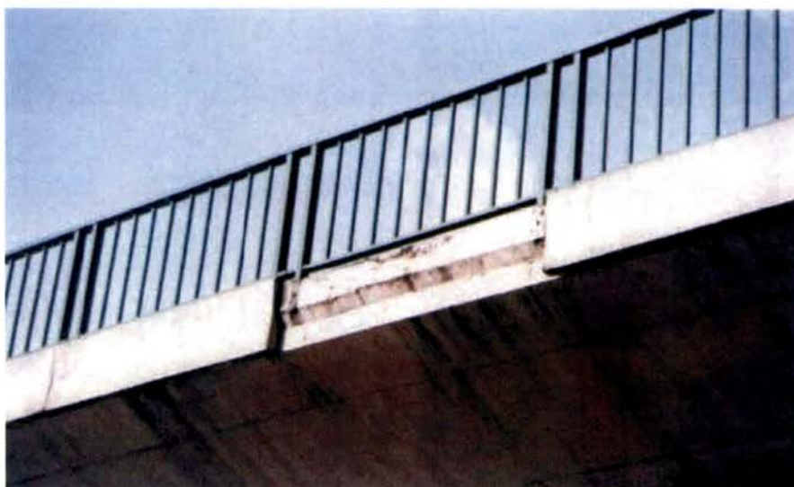
Vue générale après dépose d'une corniche
