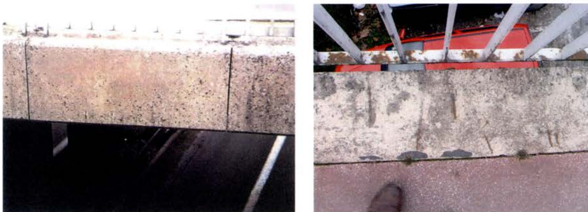
Figure 34. Exemples d'armatures visibles en peau
