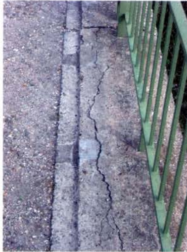
Figure 46. Fracture au niveau du liaisonnement
