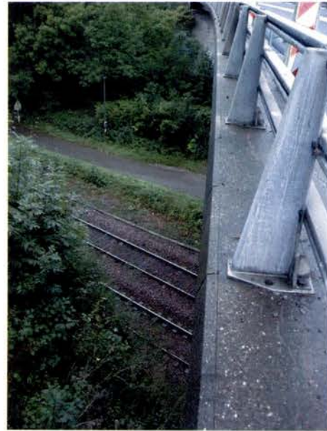
Figure 17. Exemple de liaison par contre-corniche
