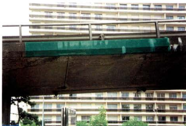
Figure 61. Mise en sécurité d'une corniche par l'emploi d'un filet
