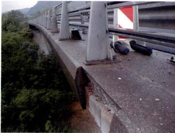
Figure 18 : Chute d'un élément de corniche par rupture de la liaison.
