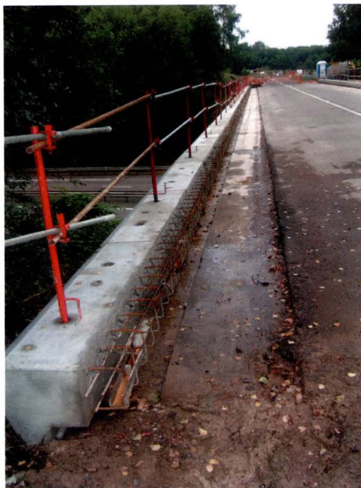
Figure 65. Remplacement de tous les éléments de corniche
