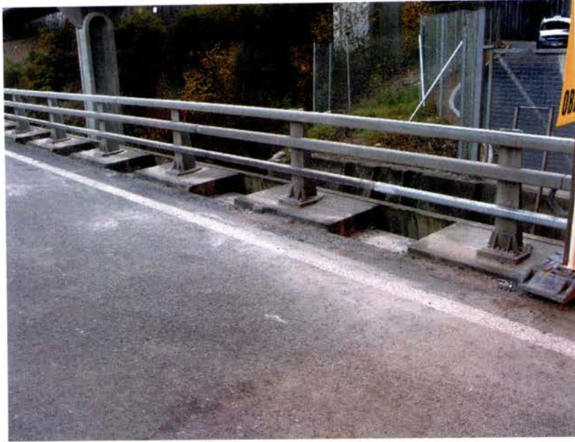
Figure 71. Vue d'une corniche d'habillage depuis le tablier
