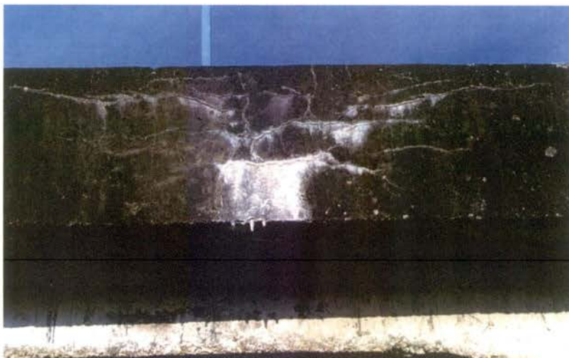
Figure 27. Exemple de fissures calcifiées
