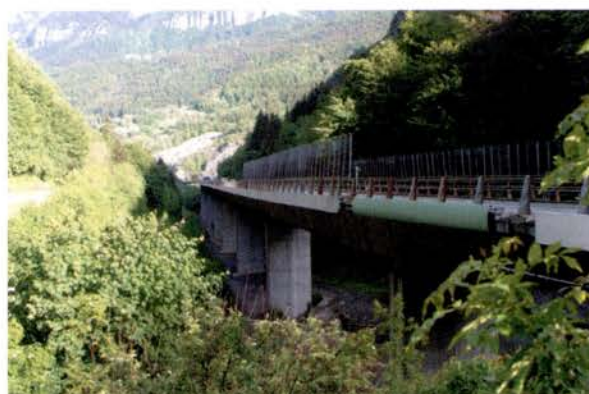
Figure 76. Remplacement de quelques éléments par des corniches métalliques (zone test)
