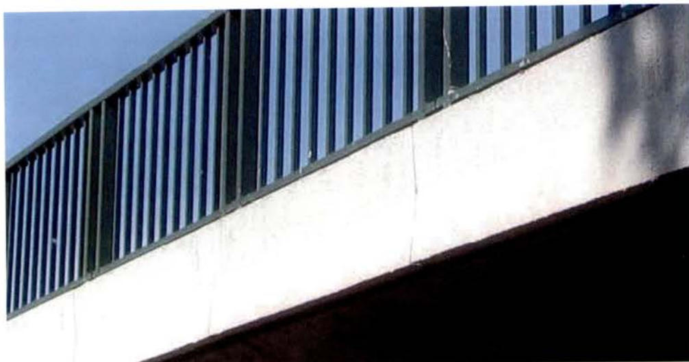
Vue générale des corniches
