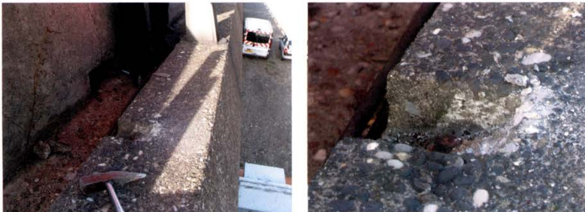
Figure 43. Fixation de corniches par goujons verticaux
