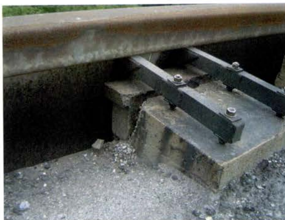
Figure 75. Réparation de la liaison d'une corniche au tablier par adjonction d'éléments métalliques
