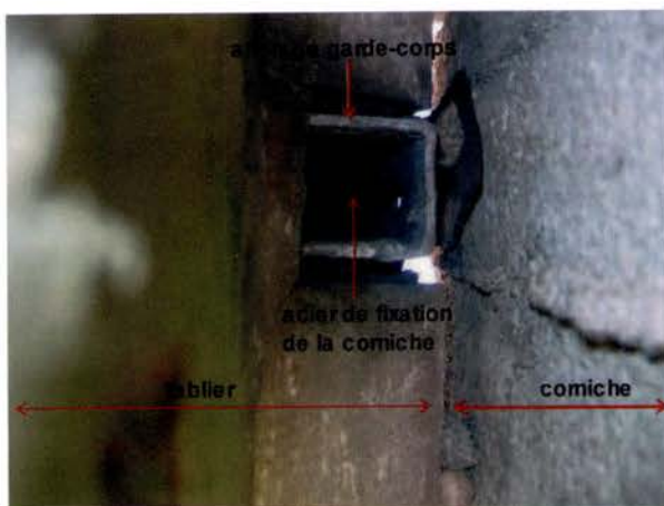
Vue de dessous : fixation de la corniche dans un ancrage du garde-corps
