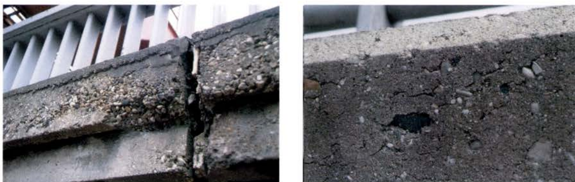
Figure 31. Deux exemples d'hétérogénéité de type « nids de cailloux »
