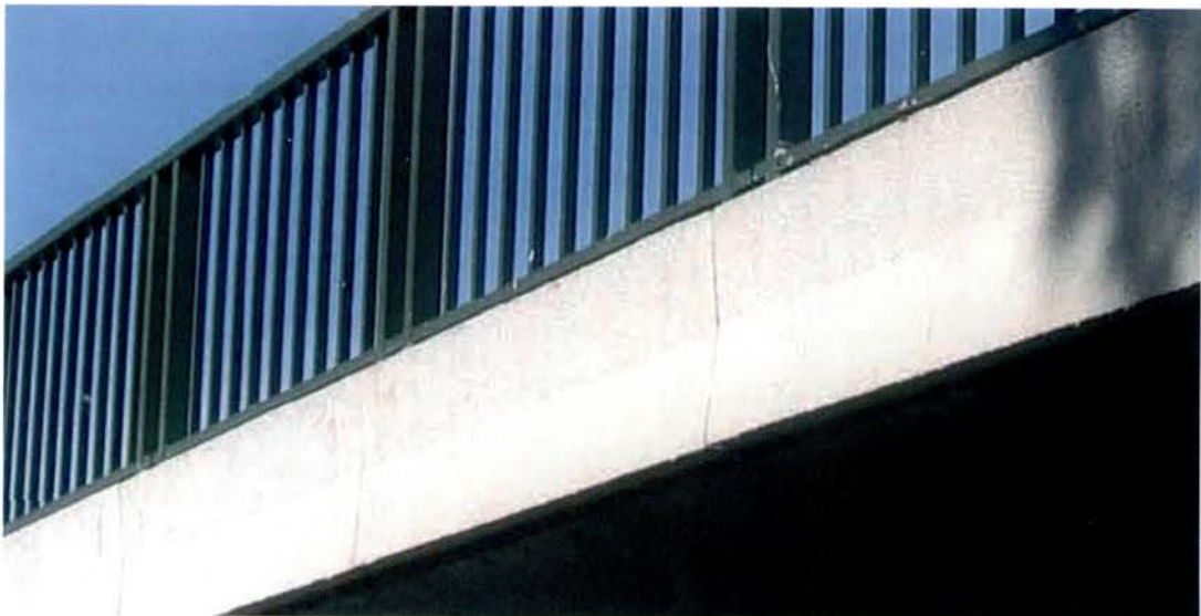
Vue générale après réparations
