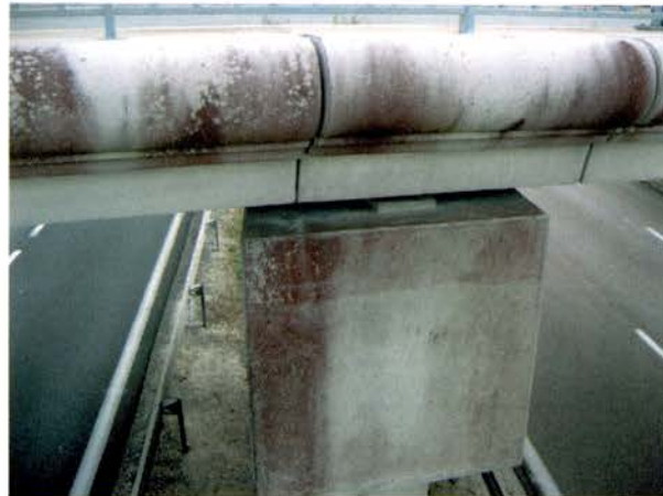
Figure 29. Parement d'une corniche avec variation de la teinte
