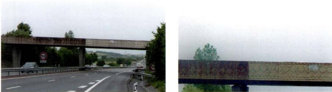
Figure 62. Aspect d'une corniche architecturée après nettoyage
