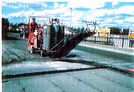
Figure 85. Exemple de machine de rabotage avec plaque de chauffe en petite largeur
