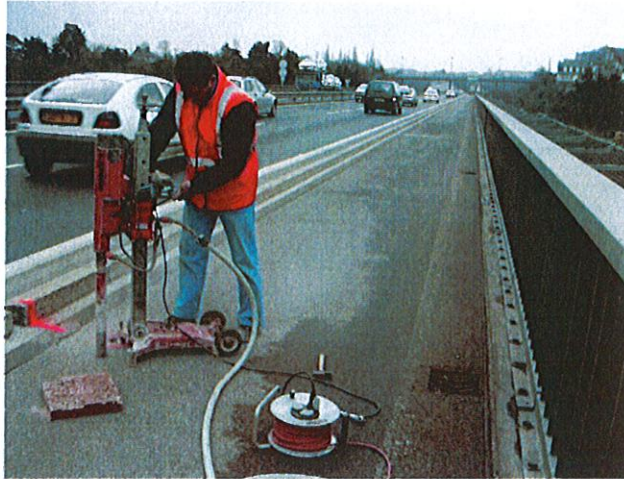
Figure 136. Réalisation d'un carottage d'étalonnage
