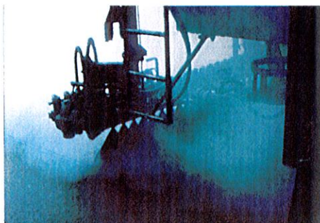
Figure 7. Application par rampe de projection du liant bitume-polymère d'un complexe MHC
