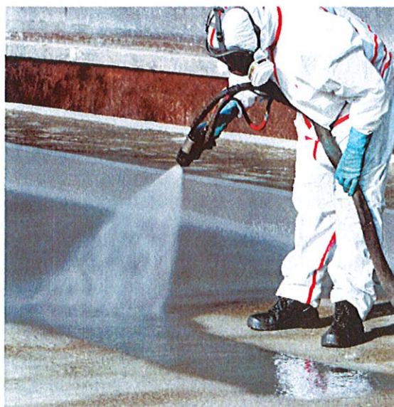
Figure 6. Mise en œuvre de résine sur un pont
