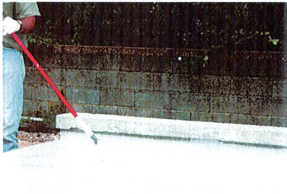
a) Mise en œuvre au rouleau
