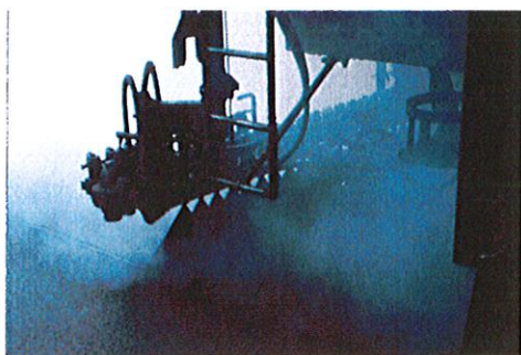
a) Application de la membrane en bitume pur
