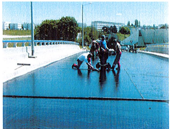
b) Application manuelle de l'asphalte gravillonné
