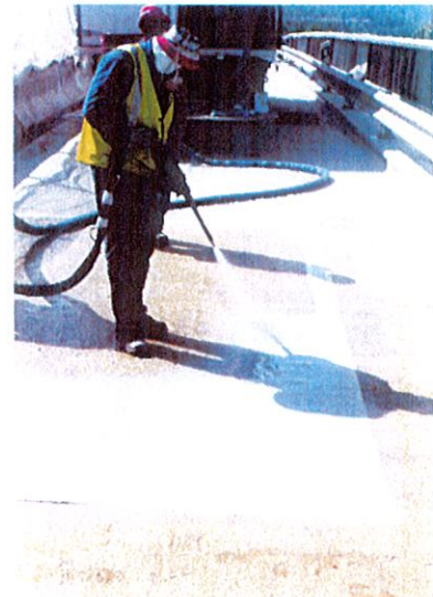
b) Mise en œuvre au pistolet
