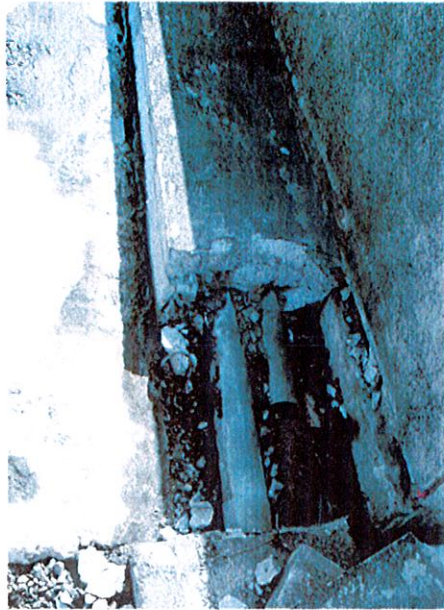
Figure 82. Trottoir avec fourreaux, dont la bordure a été enlevée
