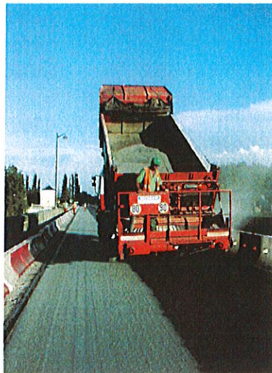
b) Application de la protection de la membrane
