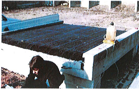
Figure 126. Vue de la dalle test recouverte de la couche de béton bitumineux
