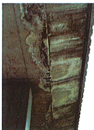
Figure 36. Absence de larmiers, ruissellement le long du parement
