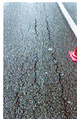
Figure 52. Orniérage accompagné d'un réseau de fissures longitudinales dans la couche de roulement
