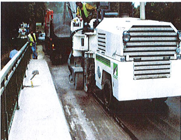
Figure 102. Vue du rabotage d'une chaussée d'ouvrage d'art
