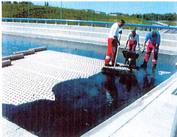
a) Mise en œuvre de la couche d'asphalte pur en semi-indépendance
