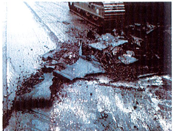
Figure 105. Aspect du tablier après décapage de l'ensemble couche d'étanchéité / roulement
