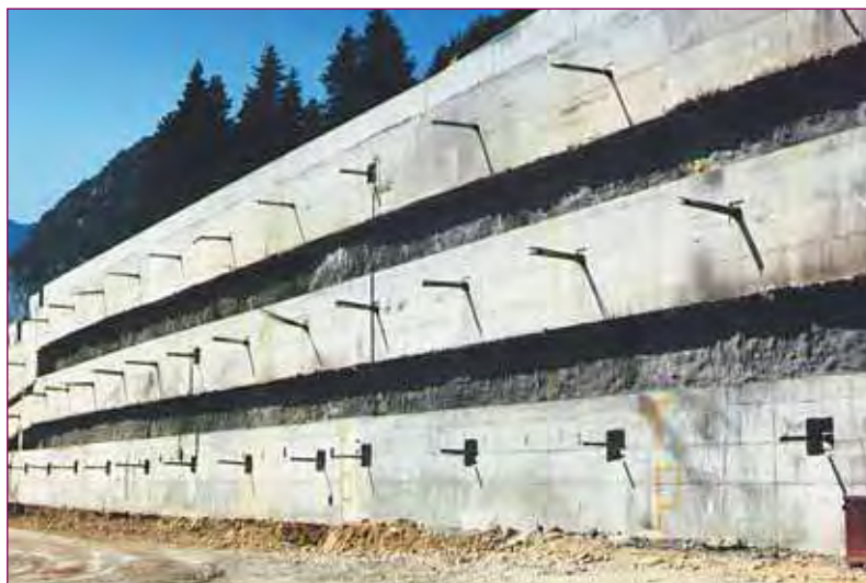
FIGURE 6 - Exécution de poutres ancrées.
