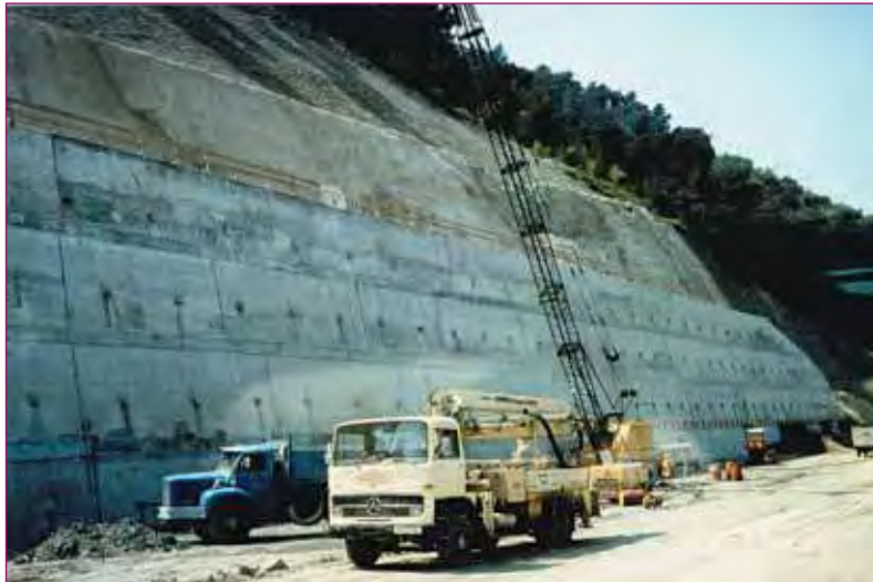
FIGURE 5 - Exécution d'un voile ancré.
