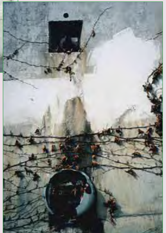
e. Capot détérioré (choc de véhicule).
