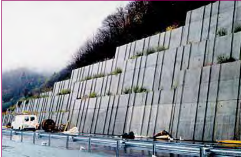
FIGURE 4 - Vue d'un ouvrage ancré avec risbermes.
