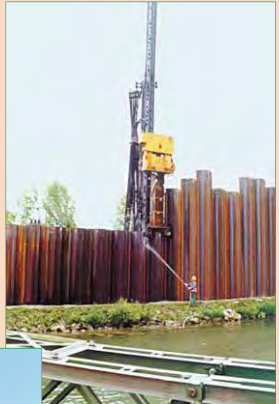
b. Fonçage par vibration.
