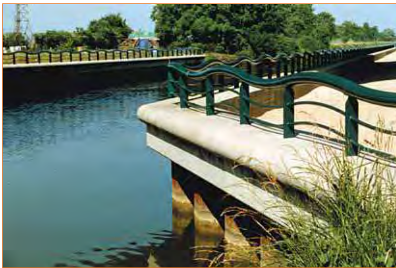
FIGURE 8 - Fixation d'un garde-corps sur la poutre de couronnement d'un rideau de palplanches.
