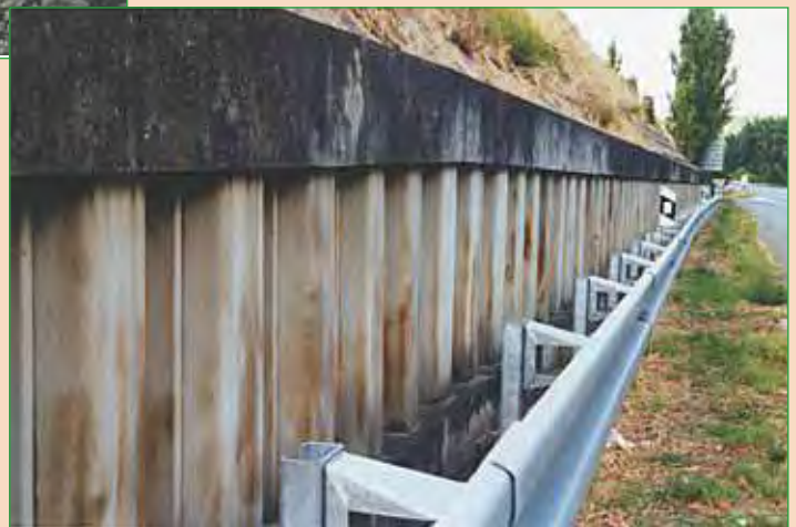
b. Soutènement d'un talus de déblai.
