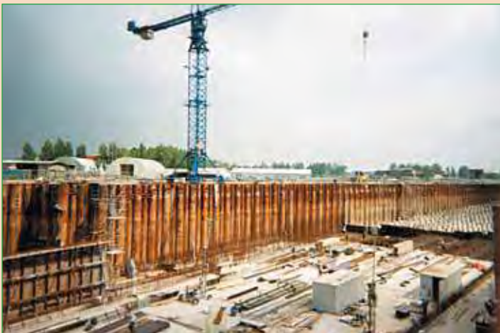
c. Soutènement d'une excavation pour la réalisation d'un passage sous-fluvial.
