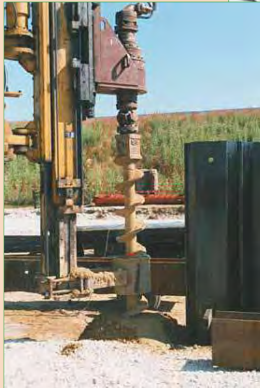
c. Préforage avant fonçage.
