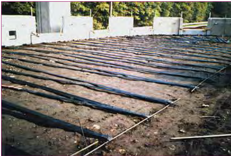
FIGURE 18 - Exemple d'ouvrage renforcé par bandes. (Paraweb de Freyssisol)
