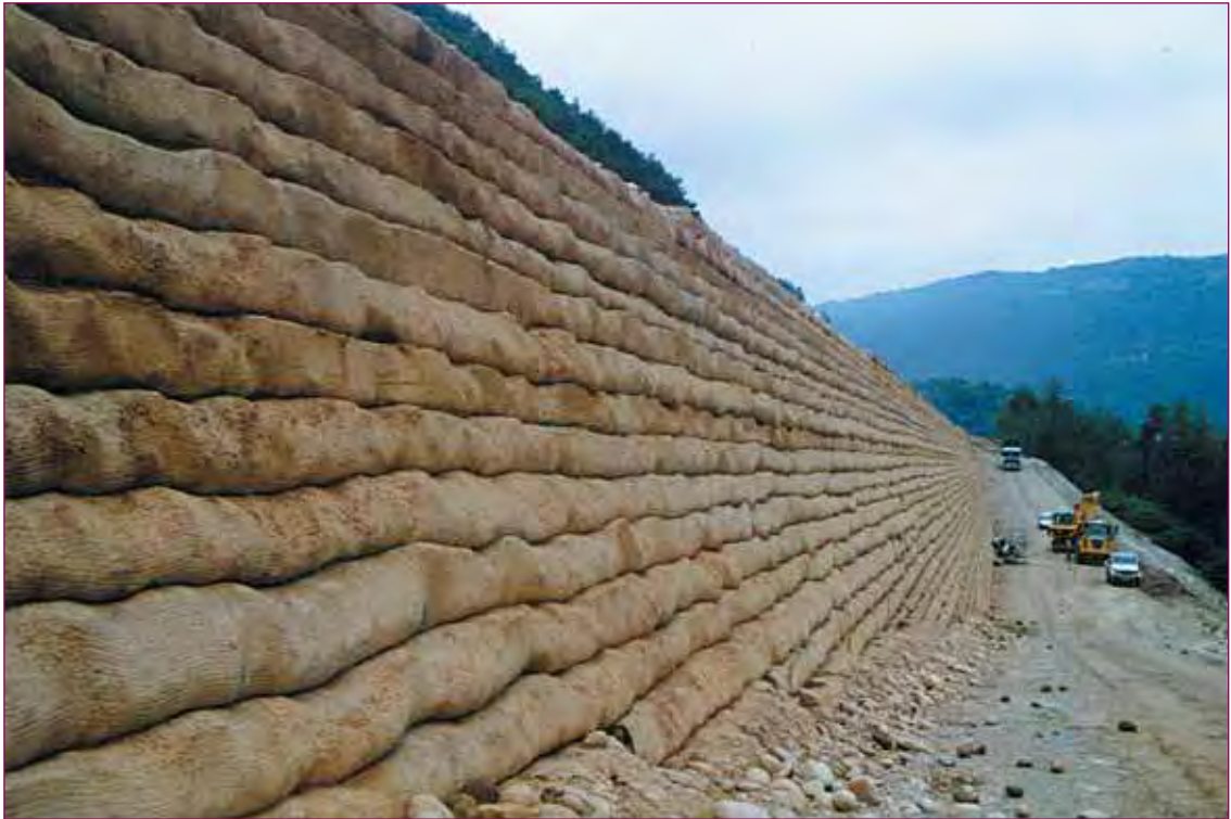
FIGURE 7 - Ouvrage en remblai renforcé du contournement de Foix, avant végétalisation.
