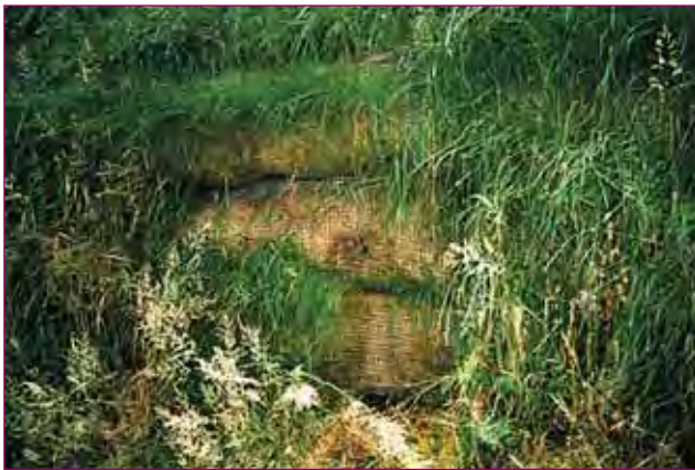
FIGURE 8 - Détail du géotextile retenant la terre végétale.
