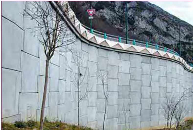
FIGURE 17 - Ouvrage renforcé par bandes avec un parement de type écailles. (Paraweb de Freyssisol - RN21 à Lourdes)
