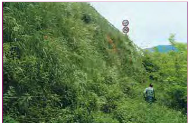
FIGURE 9 - Exemple de parement végétalisé depuis six ans (Foix - Tarascon).
