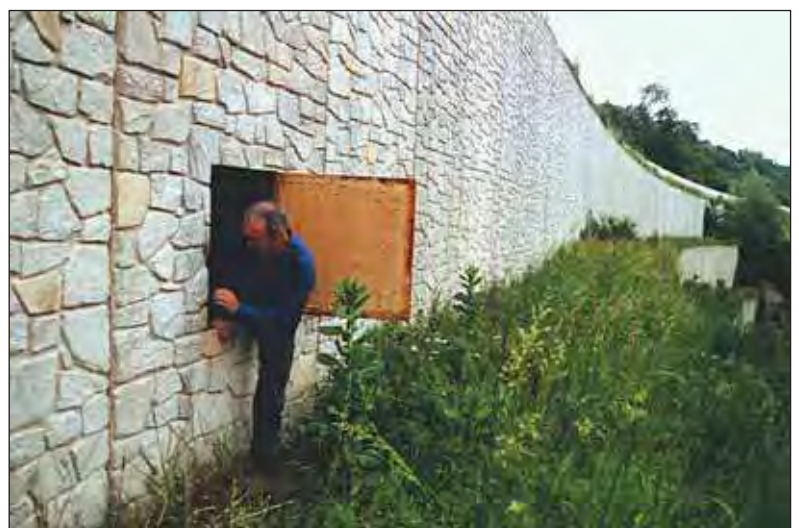
FIGURE 13 - Exemple de trappe de visite.
