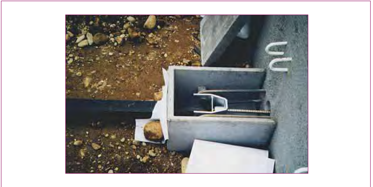
FIGURE 22 - Détail photographique d'une bande témoin non extractible et réutilisable.
