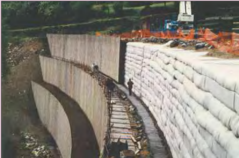
a. Pendant la construction
