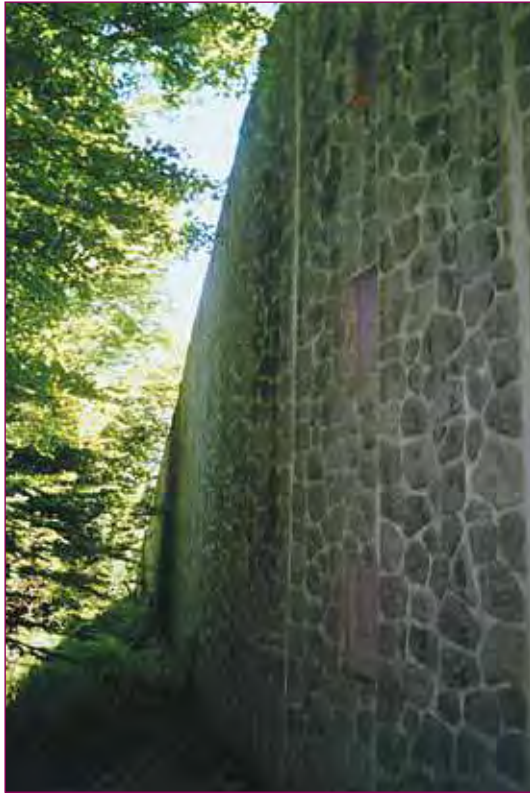
FIGURE 10 - Ouvrage renforcé EBAL - LCPC de l'Hospice de France - Vue du parement.
