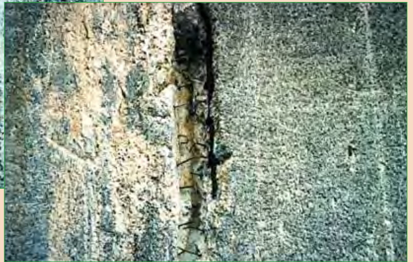
b. Armatures principales et secondaires visibles.
