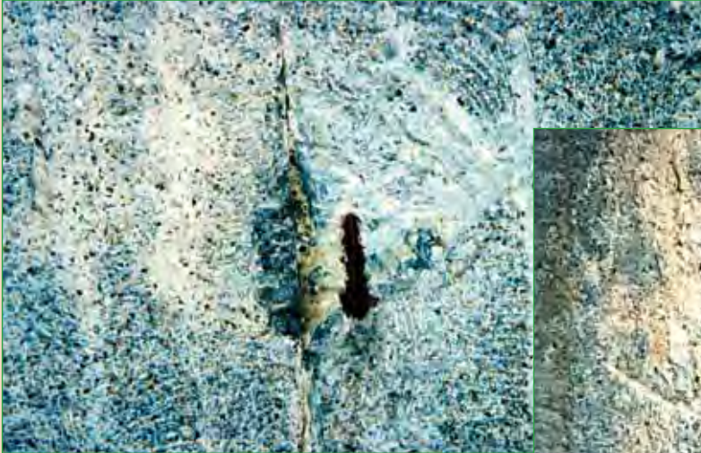
a. Armature principale visible.
