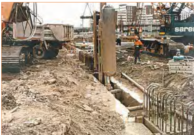
FIGURE 4 - Perforation à la benne preneuse entre les murettes guides.
