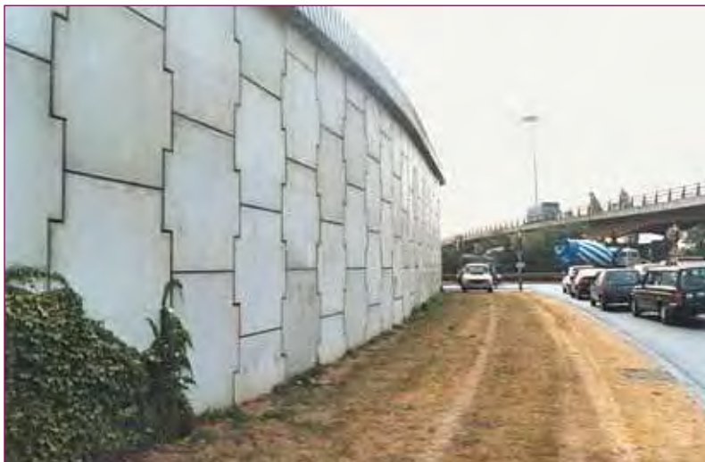
FIGURE 9 - Parement en béton du procédé « Terre Armée » constitué d'écailles cruciformes.
