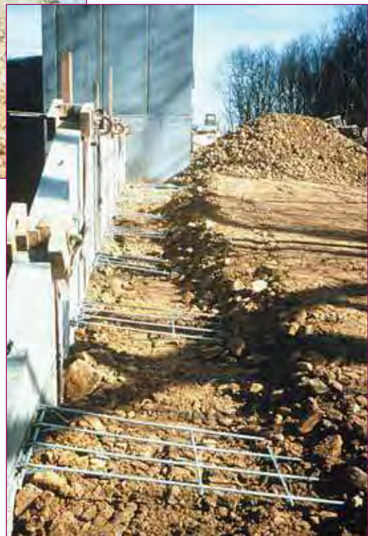
FIGURE 7 - Panneau de treillis soudé du procédé « VSol ».
