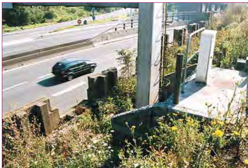
FIGURE 21 - Massif de portique de signalisation rapporté.
