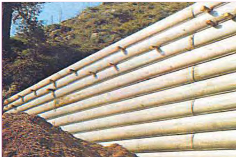
FIGURE 8 - Parement métallique du procédé « Terre Armée ».
