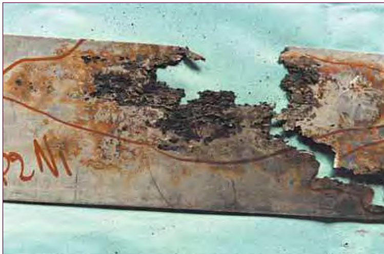
FIGURE 33 - Corrosion perforante d'une armature en acier inoxydable.
