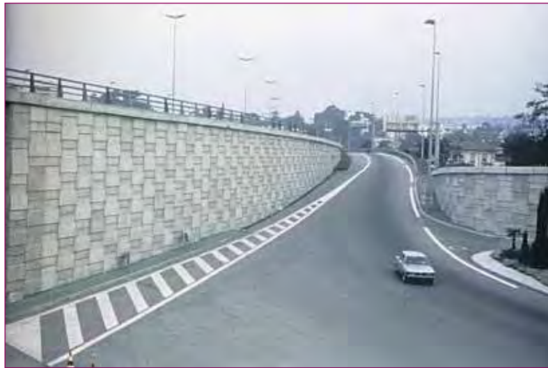
FIGURE 3 - Mur de soutènement d'une rampe d'accès à un ouvrage d'art.
