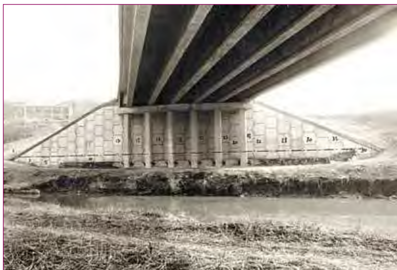
FIGURE 22 - Culée mixte de grande hauteur.
