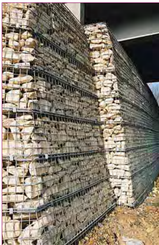
FIGURE 10 - Parement en treillis soudé du procédé « Terratrel ».
