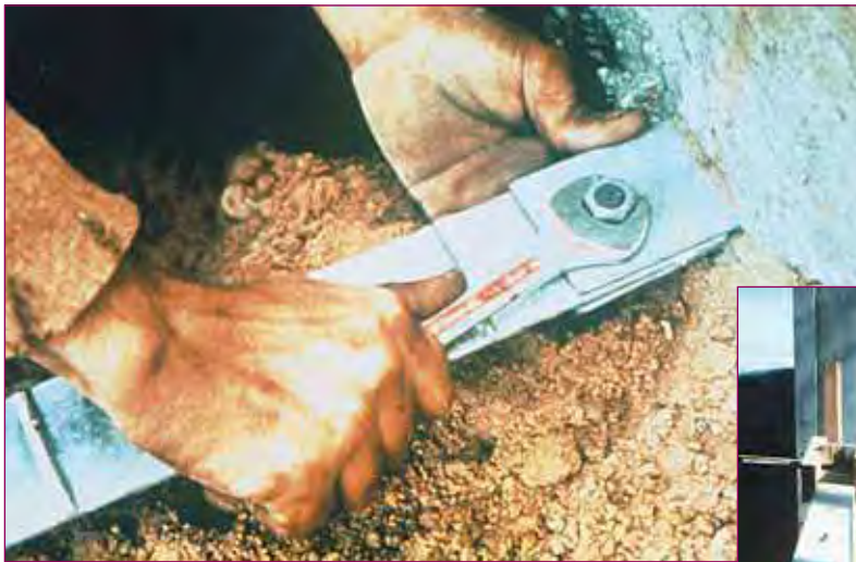
FIGURE 6 - Armature du procédé « Terre Armée » boulonnée.
