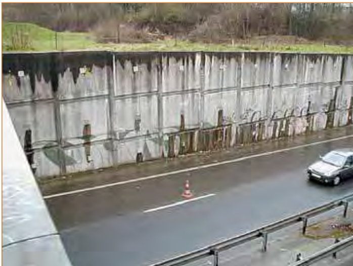
FIGURE 5 - Paroi parisienne à Champ-sur-Marne.
