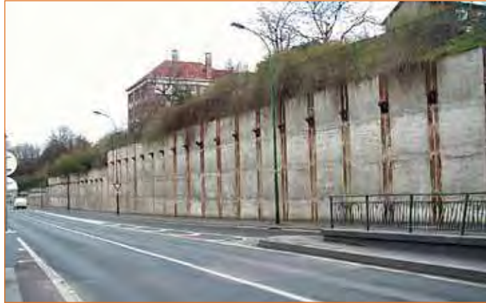
FIGURE 2 - Vue générale d'une paroi Berlinoise à Saint-Ouen.
