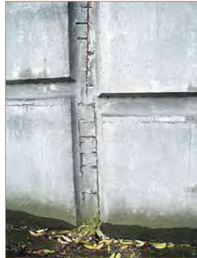
FIGURE 12 - Poteaux préfabriqués. Aciers apparents.
