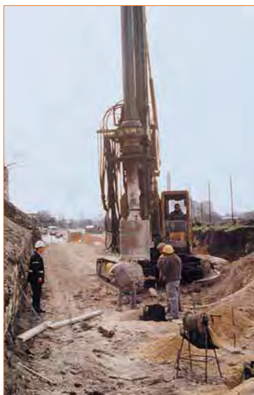
FIGURE 3 - Forage et mise en place des profilés métalliques.
