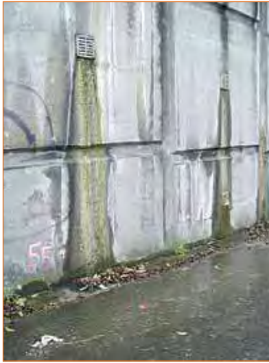
FIGURE 11 - Drains subhorizontaux. Écoulement en parement.
