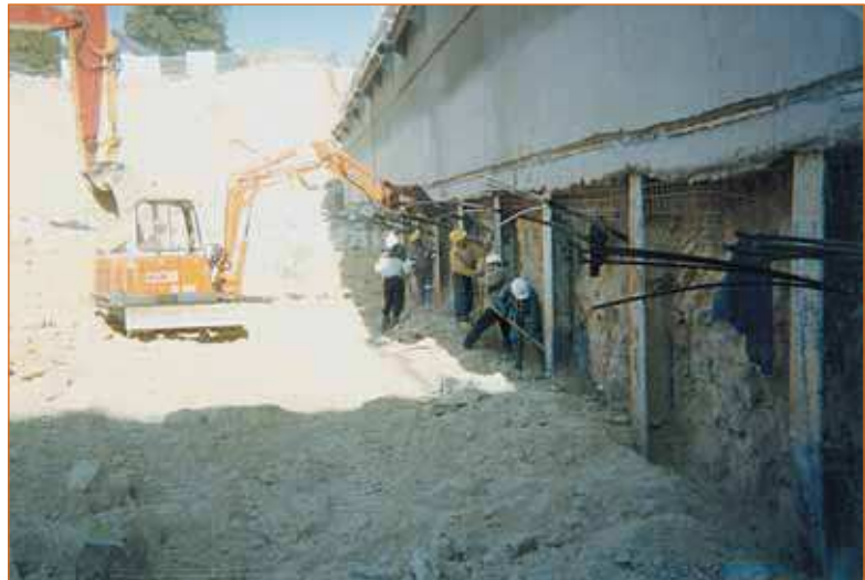
FIGURE 4 - Paroi Berlinoise en cours d'exécution.
