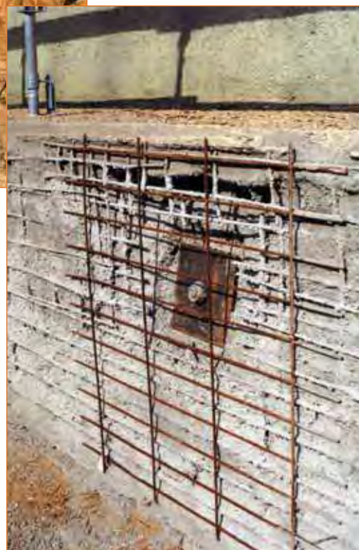
FIGURE 8 - Détail d'une tête de clou, cas des barres en acier à haute adhérence pour béton armé.
