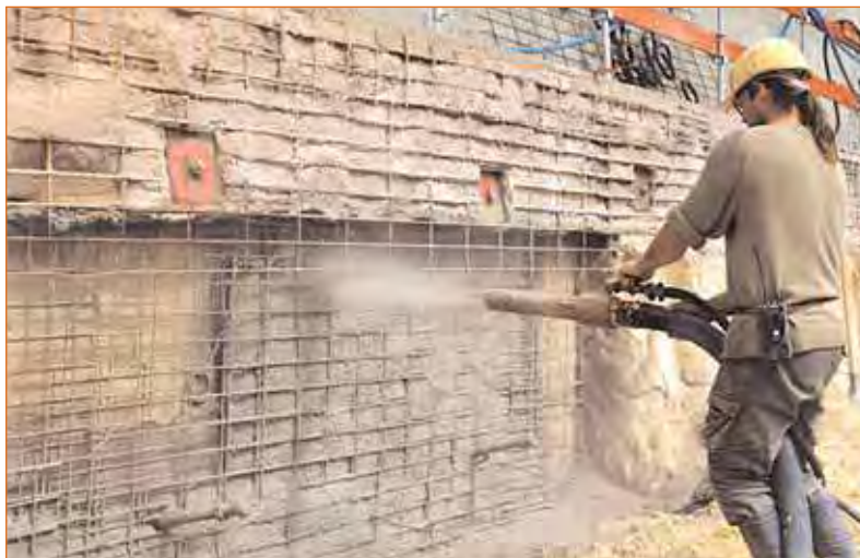
FIGURE 6 - Réalisation du parement par béton projeté.
