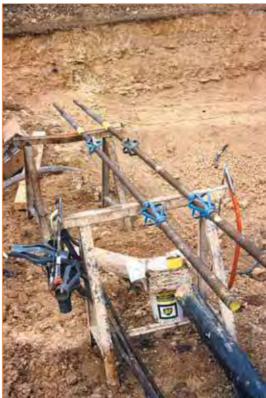
FIGURE 5 - Vue des aciers haute adhérence constituant les armatures des clous.
