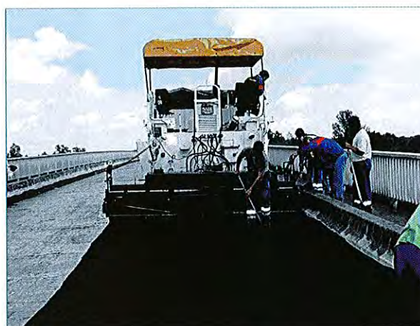
Figure 24 – Mise en œuvre au finisseur par demi-chaussée de la couche de reprofilage
