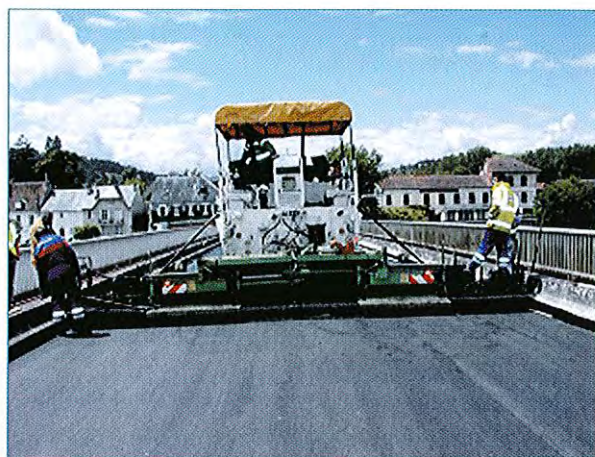
Mise en œuvre au finisseur en pleine largeur de la couche de reprofilage
