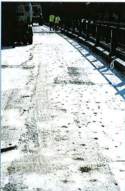
Impacts ponctuels du BRH sur le tablier
