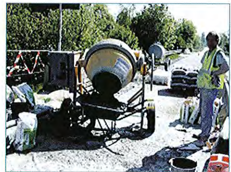
Figure 15 – Gâchage sur chantier d'un matériau LHM livré en kit
