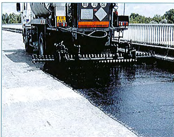
Épandage de couche d'accrochage sur le support béton (attention au peignage)
