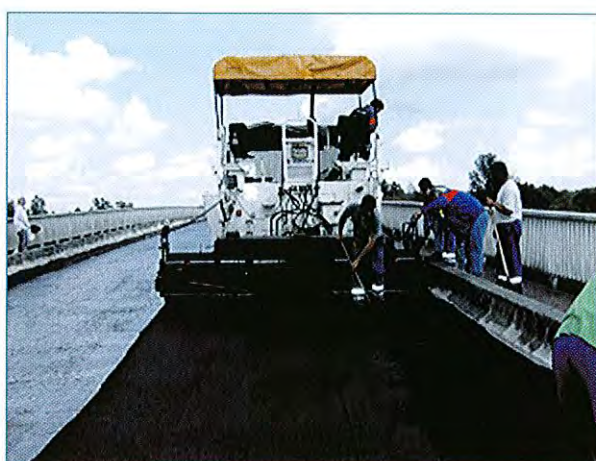
Mise en œuvre au finisseur demi-chaussée de la couche de reprofilage
