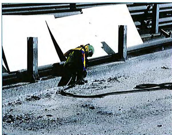
Préparation de surface soignée (ici décapage par projection d'abrasif) des zones d'arrêts d'étanchéité et de couche de reprofilage en micro béton bitumineux
