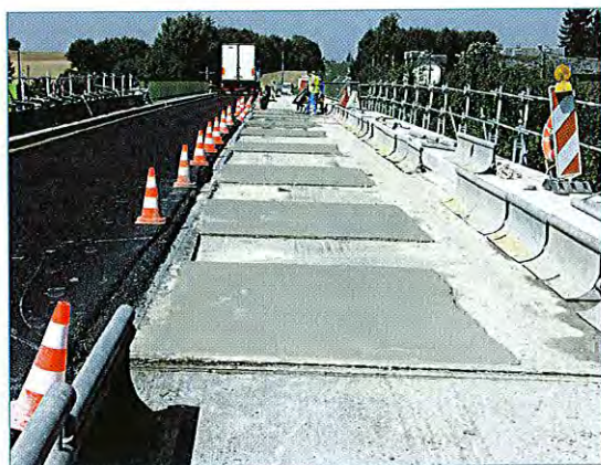
Figure 18a et 18b – Mise en place par plot au râteau et à la truelle (à noter les stries sur le béton du tablier dues au rabotage)
