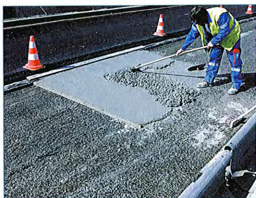
Figure 18a et 18b – Mise en place par plot au râteau et à la truelle (à noter les stries sur le béton du tablier dues au rabotage)
