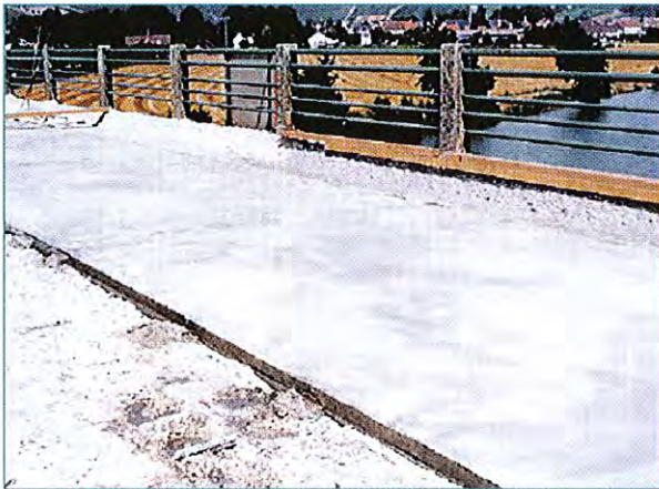
Renformis réalisé (sans joint sec) sur une voie
