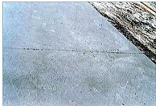
Aspect d'un joint sec
