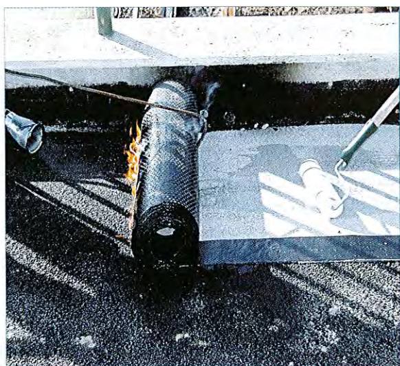
Figure 27 – Soudage manuel de chape FPM sur la couche de reprofilage ; le soudage par machine automatique est à privilégier
