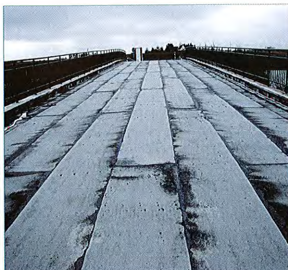
Figure 28 – Aspect de la chape d'étanchéité FPM terminée
