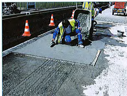
Figure 18a et 18b – Mise en place par plot au râteau et à la truelle (à noter les stries sur le béton du tablier dues au rabotage)
