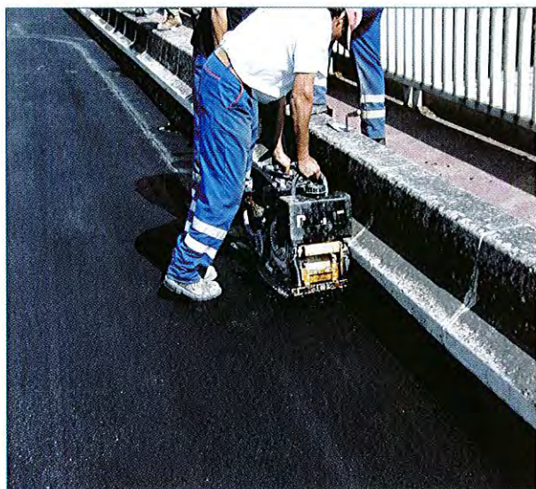
Compactage sous bordure à la plaque vibrante
