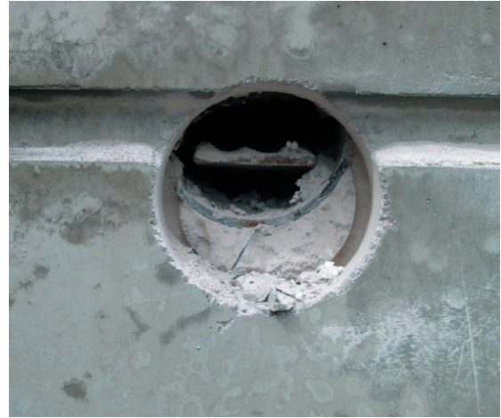
Photo 15. Vue de l'amorce dans sa réservation
