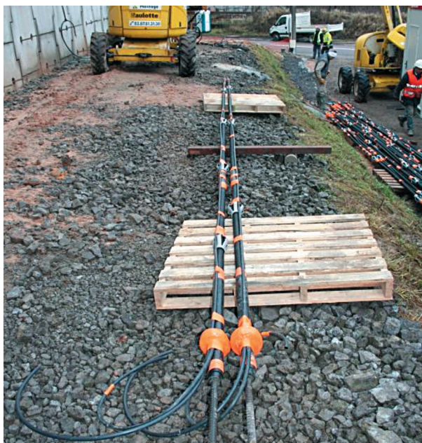
Photo 36. Exemple de stockage sur site de clous préfabriqués en usine.
