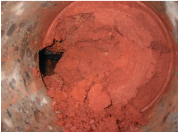
Photo 25. Début d'extraction du remblai depuis le carottage en parement
