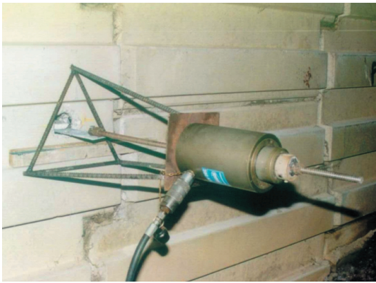
Photo 16. Extraction du témoin à l'aide d'un trépied et d'un vérin
