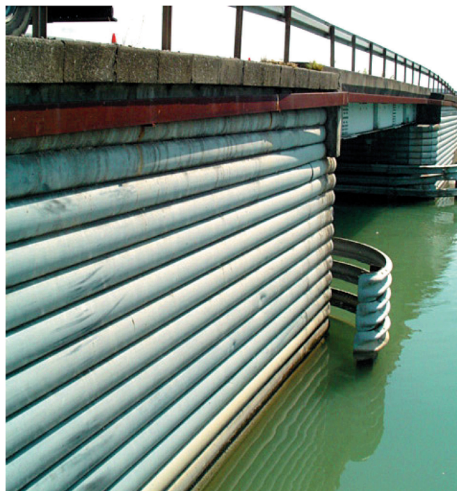
Photo 1. Première culée de pont en Terre Armée® avec parement métallique, construite en 1969.
