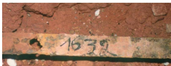
Photo 31. Vue d'une armature dans une fouille
