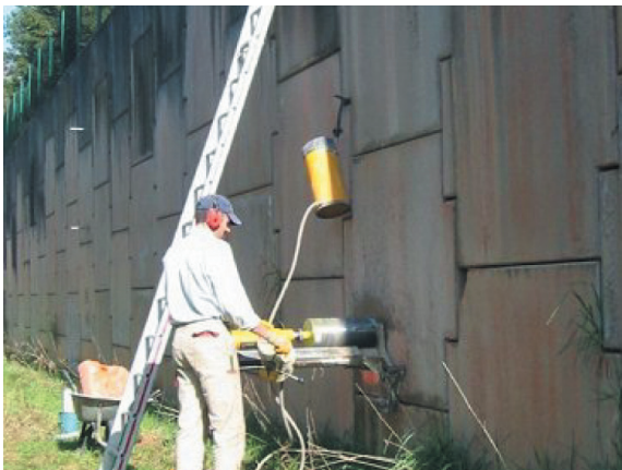
Photo 23. Réalisation du carottage en parement
