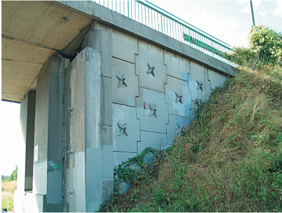
Photo 34. Renforcement par clouage écaille par écaille
