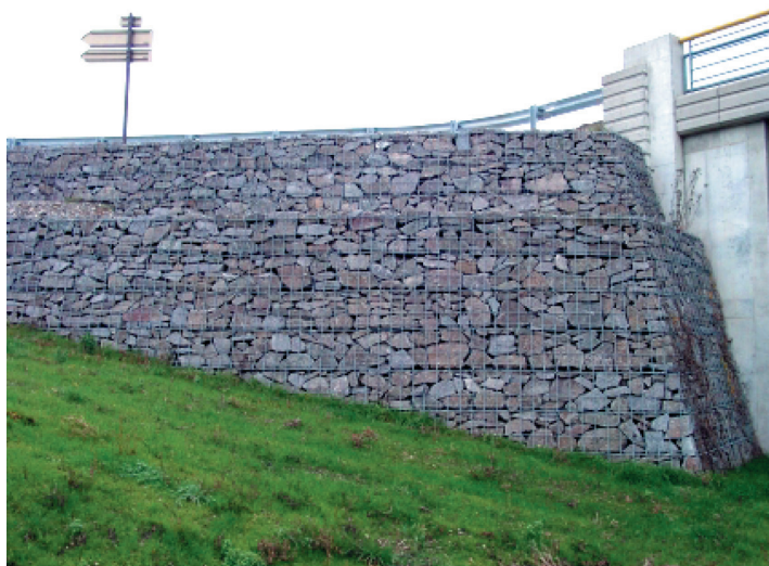
Photo 3. Parement en treillis soudés, Procédé TerraTrel®
