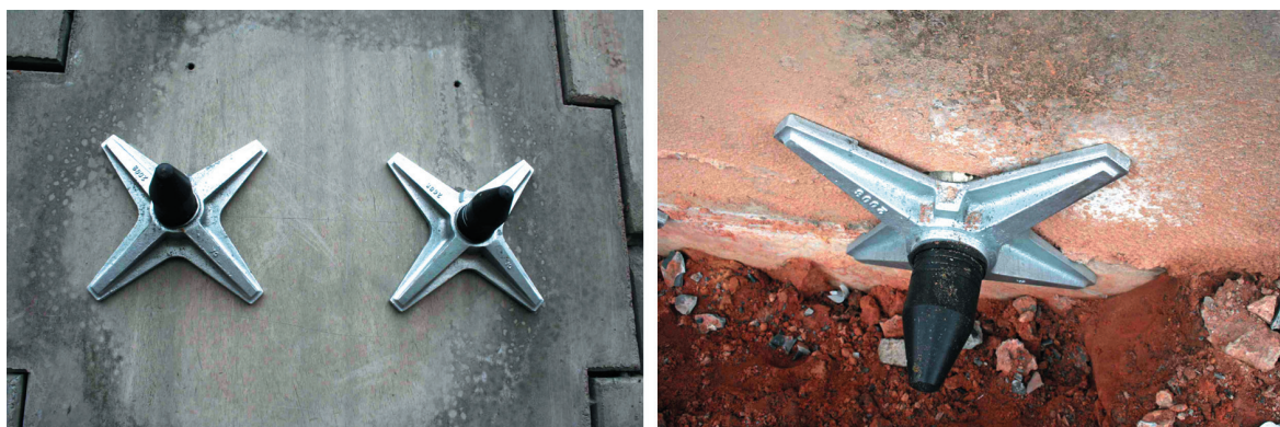
Photo 39. Capot de protection des têtes de clous
