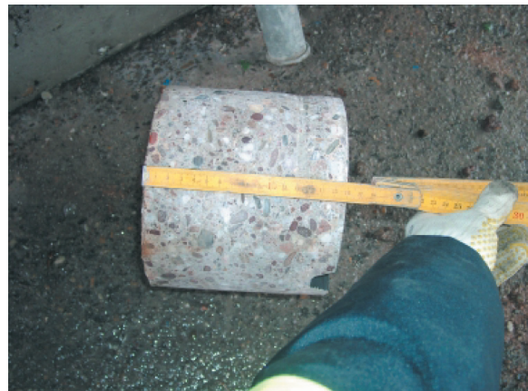
Photo 24. Dépose de la carotte béton
