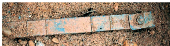
Photo 5. Armature métallique à haute adhérence en bande (photo CETE de l'EST)
