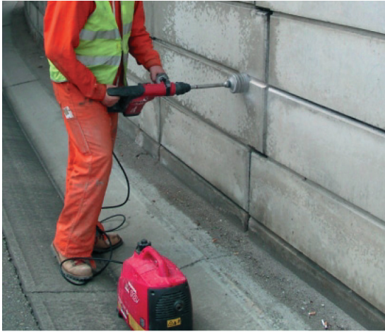
Photo 14. Découpage de l'opercule à l'aide d'une scie cloche
