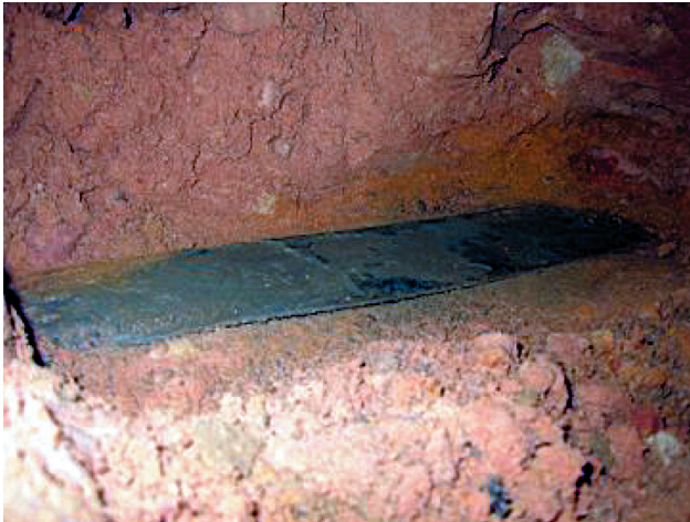
Photo 27. Observation de l'armature in situ
