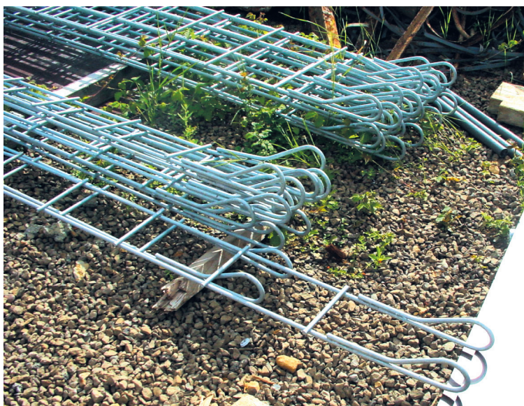
Photo 6. Armatures métalliques en treillis soudés (photo CETE de l'EST)
