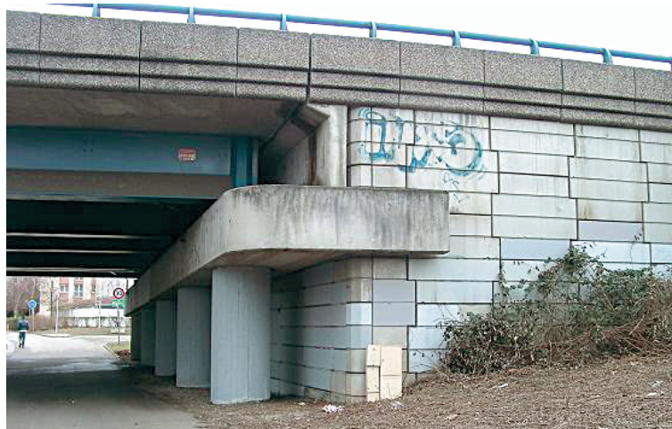
Photo 9. Exemple de culée mixte avec massif de soutènement en Terre Armée®
