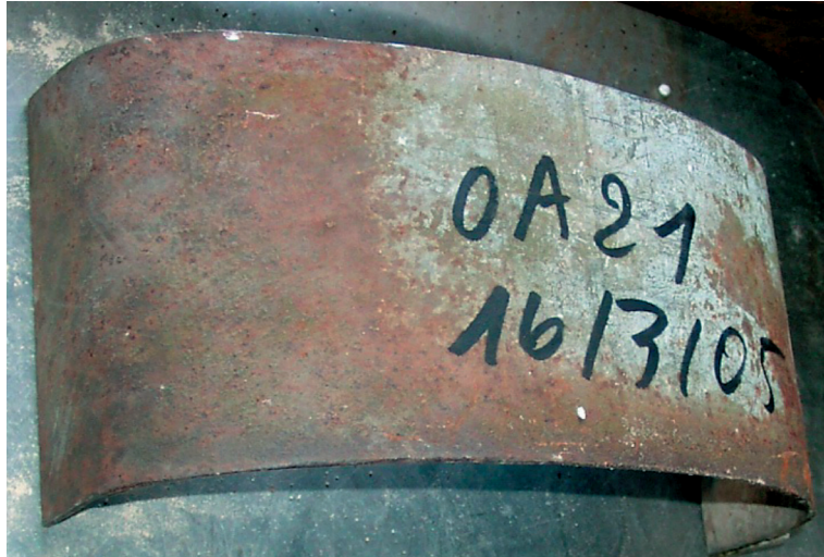
Photo 8. Élément de parement métallique en acier galvanisé extrait d'un mur existant
