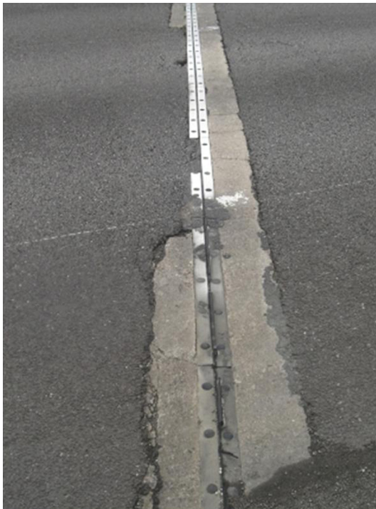
Contact tablier / mur garde-grève
