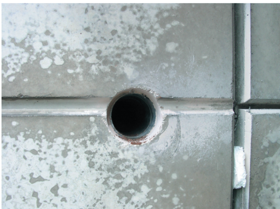
Photo 19. Vue de l'écaille après extraction du témoin
