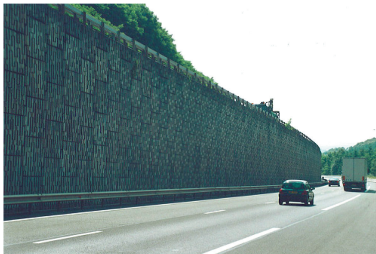
Photo 10. Exemple de mur de soutènement en Terre Armée®
