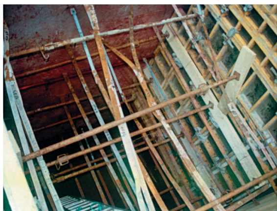
Photo 30. Vue de dessus d'une grande fouille
