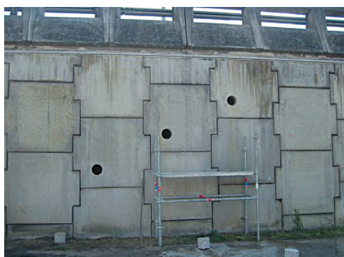
Photo 22. Implantation des carottages en parement du mur
