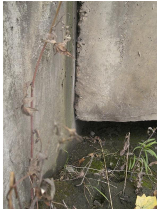
Lèvres des joints en contact
