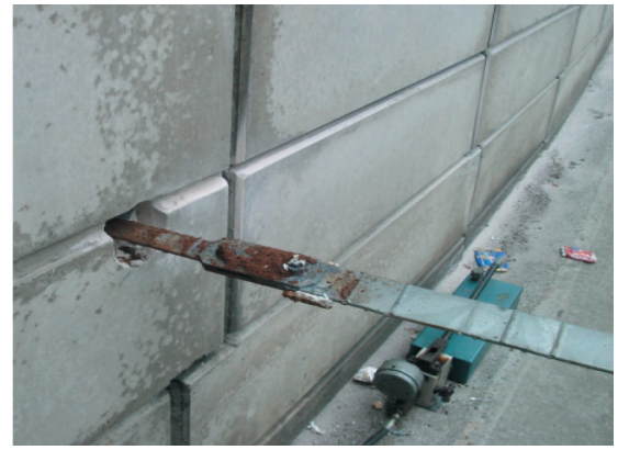
Photo 17. Témoin en cours d'extraction, on distingue l'amorce, l'éclissage et le témoin
