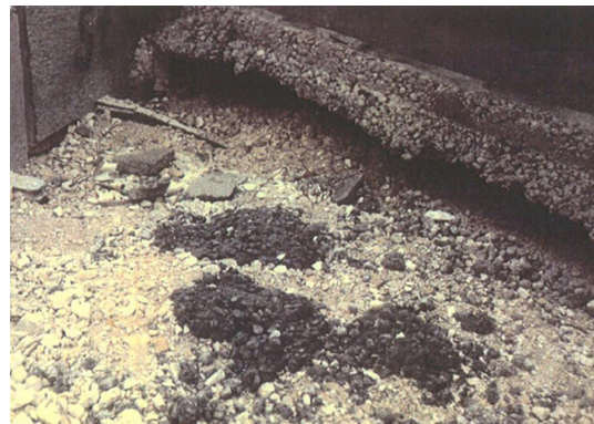
Photo 40. Détail du vide sous la dalle de transition
