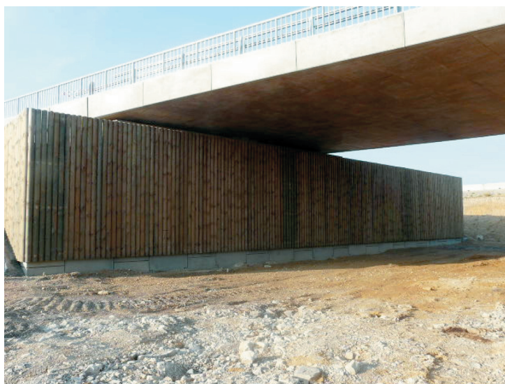
Photo 33. Habillage bois en parement d'un massif en sol renforcé
