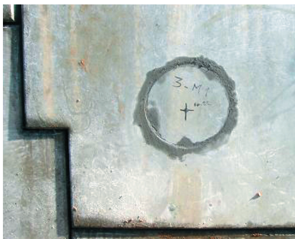
Photo 29. Scellement de la carotte extraite
