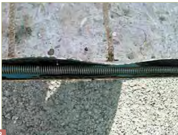
Fermeture de l'étanchéité : mise en place du drain sur le bitume.
