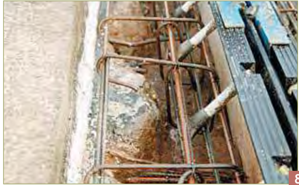
Préparation de la réservation : détail des douilles d'ancrage des éléments de joints.
