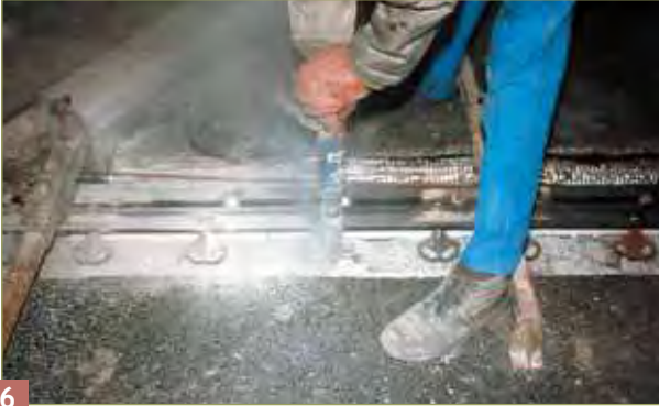
Préparation de la réservation : perçement pour scellement des armatures d'ancrage du joint.
