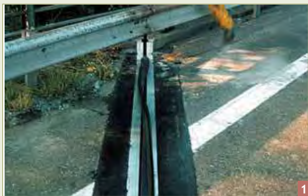
Mise en place du profilé en élastomère dans les lèvres du joint.
