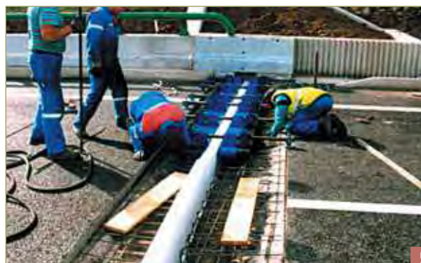
Préparation de la réservation : mise en place du ferrailage complémentaire de la feuillure.
