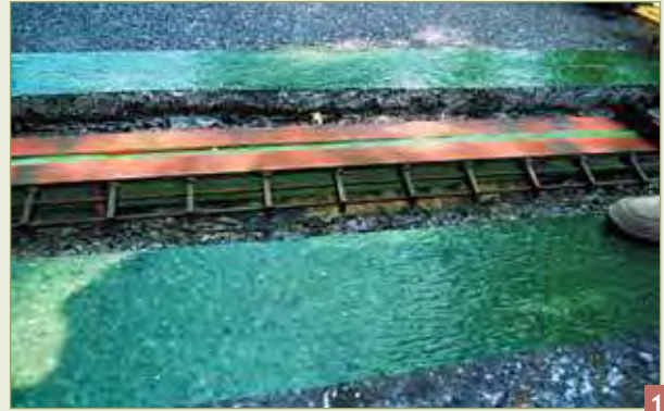
Protection de la chaussée avant coulage du solin.
