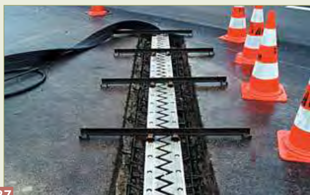
Réalisation de joint par demi-chaussée.
