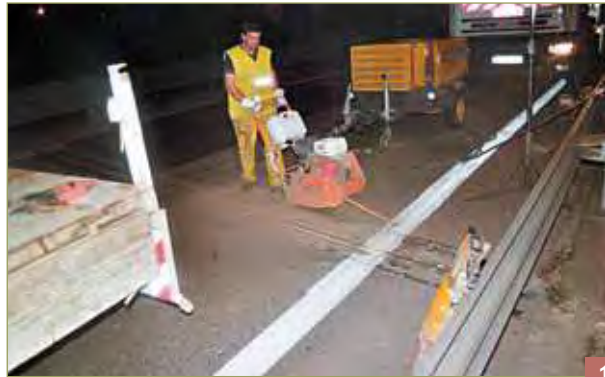
Sciage des couches de chaussée.
