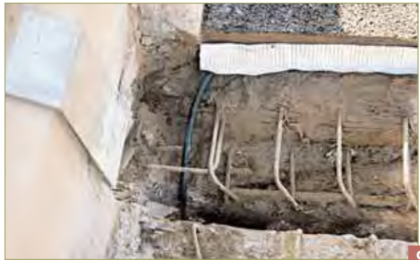
Préparation de la réservation : détail de l'évacuation du drain.
