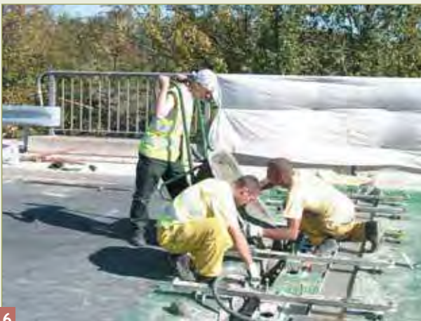
Mise en œuvre du produit de remplissage de la réservation.
