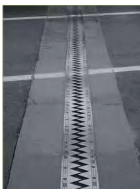
Joint type à peigne en console.
