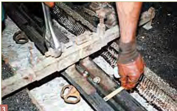
Préparation de la réservation : réglage de l'ouverture du joint.
