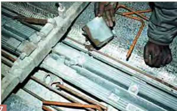
Préparation de la réservation : mise en œuvre du produit de scellement dans les forages.
