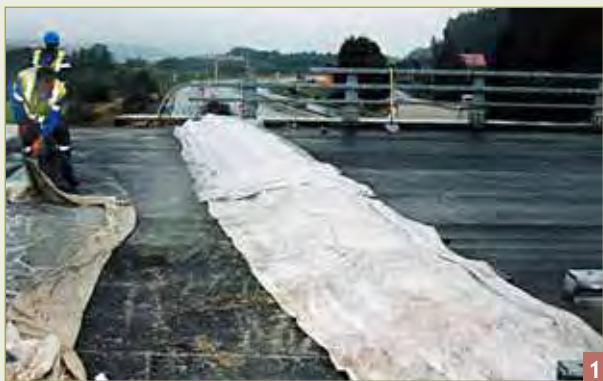
Protection du solin après bétonnage pour éviter la dessiccation.
