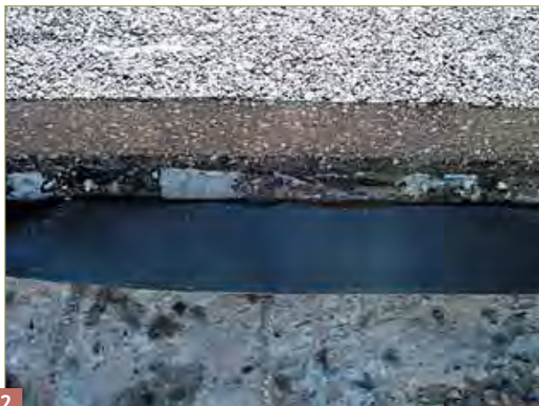
Fermeture de l'étanchéité.
