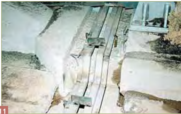
Préparation de la réservation : détail de la liaison joint de chaussée / joint de trottoir.
