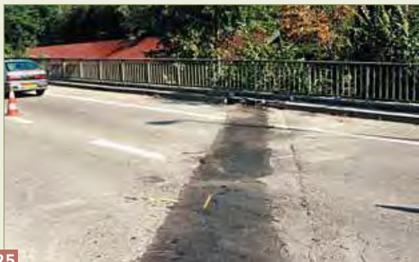
Mise en œuvre provisoire d'enrobé à froid pour ponter le joint.
