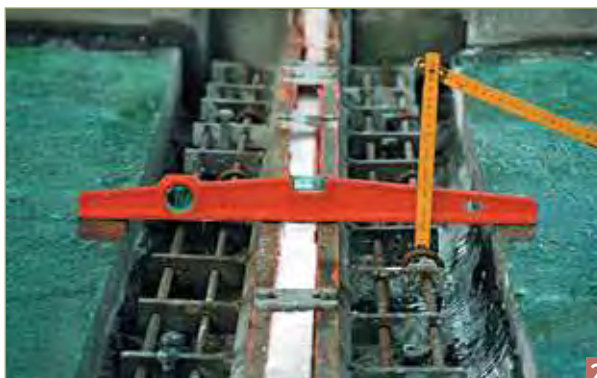
Vérification de l'enrobage des armatures du solin.
