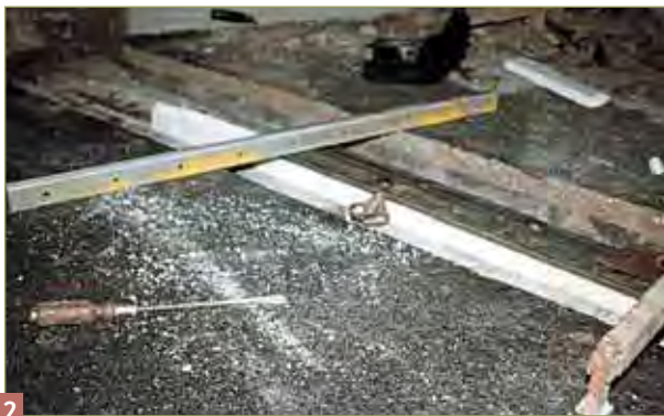
Préparation de la réservation : vérification du bon nivellement des éléments de joint.
