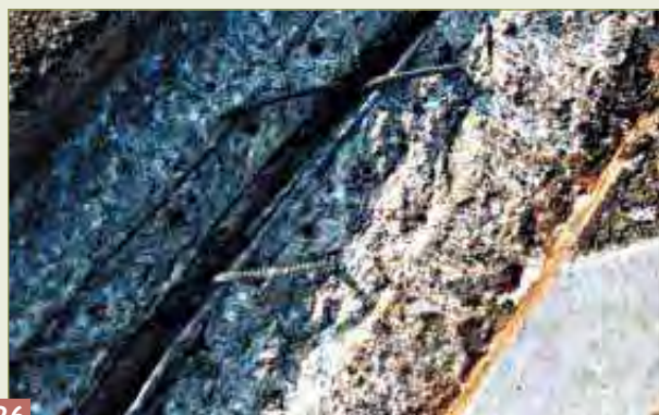
Exemple de support après démontage de l'ancien joint.
