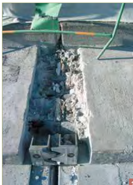
Préparation de la réservation : préparation du support sur trottoir.
