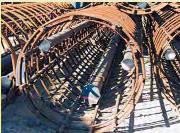
▲ Figure 20 - Tubes de réservation mal positionnés.
