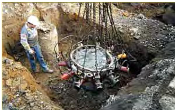
▲ Figure 3 - Recépage avec éclateur hydraulique.
