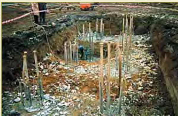
▲ **Figure 29 - Les tubes ne doivent pas dépasser la tête de pieu de plus de 0,50 m.**
