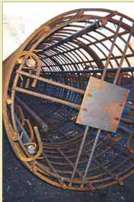
▲ Figure 21 - Exemple d'une bonne disposition relative des tubes et de la cage d'armature.
