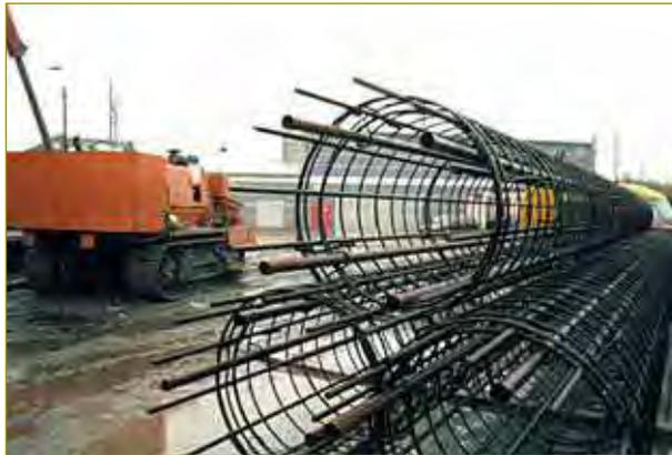
*Cette photo donne un exemple de préparation soignée : les tubes de réservation dépassent de 0,50 m de l'extrémité supérieure de la cage d'armatures. Les cages d'armatures, stockées sur des madriers, sont isolées de la boue et des éléments polluants.*
