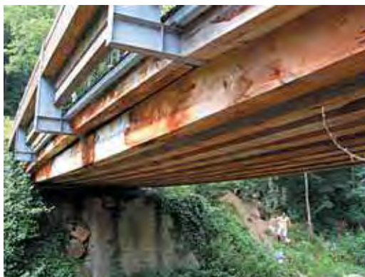
Figure 48 - Décolorations du bois inégales. Zones plus humides à ausculter.
