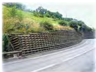
Mur de soutènement
