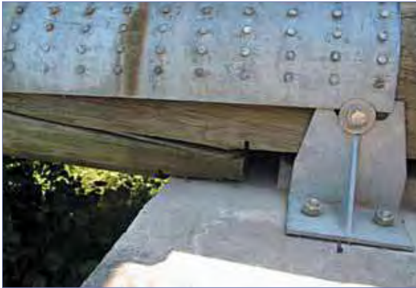
Figure 28 - Rupture du bois par traction transversale.
