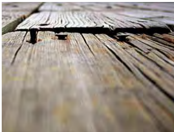
Figure 69 - Déclouement du platelage.
