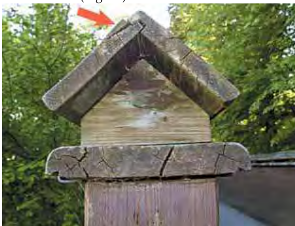
Figure 45 - Assemblage bois sur bois piégeant l'eau.
