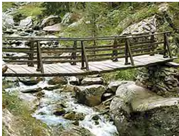
Figure 60 - Passerelle présentant une flèche importante.
