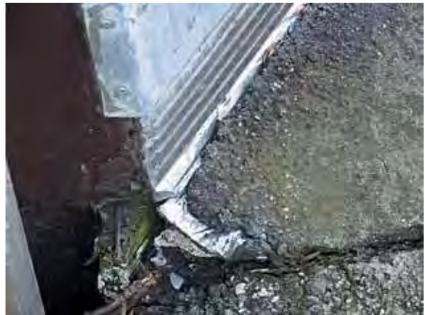
Figure 40 - Liaison poutre tablier et chaussée d'accès.
