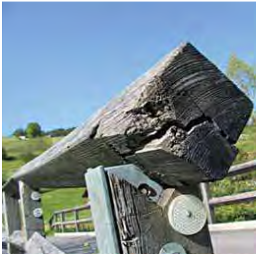
Figure 25 - Attache de la main courante sous-dimensionnée.
