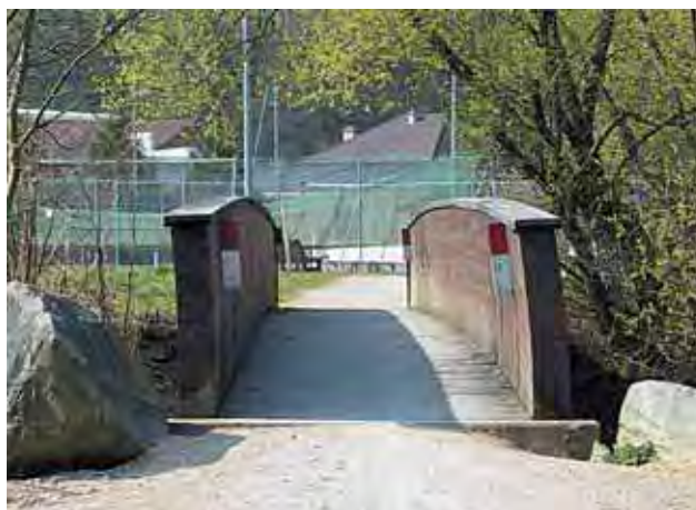
Figure 12 - Poutres latérales déversées. La face ensoleillée côté sud se rétracte.
