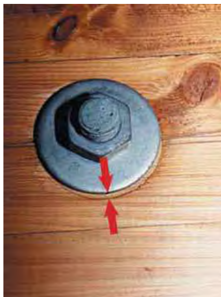
Figure 67 - Déplacement d'assemblage.
