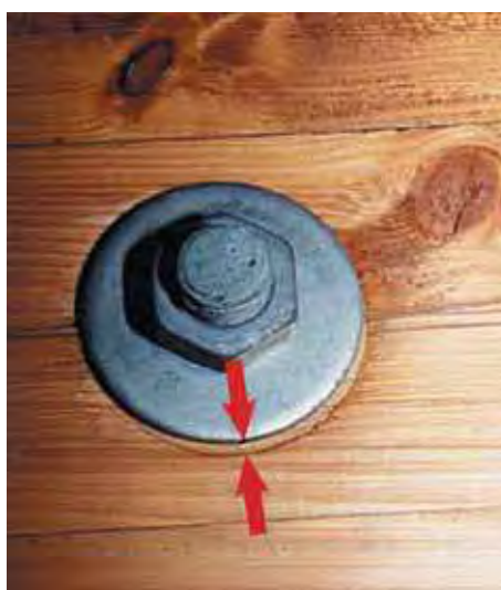
Figure 19 - Déplacement du boulon d'assemblage.
