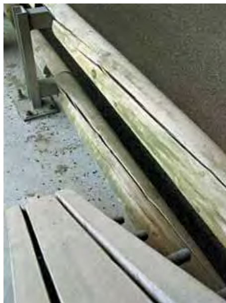
Figure 65 - Fente de retrait sur du bois rond.
