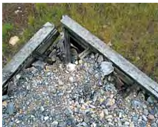
Figure 23 - Mauvaise conception du coin.
