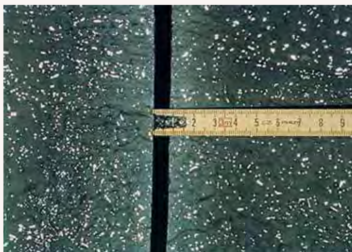
Fig. 8 – Réalisation d'une saignée par sciage à l'aide d'un fil diamanté.
