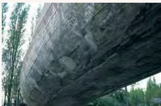
Vue de l'état avant.
