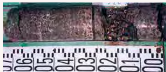
Carotte de béton.
