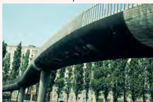
Vue générale de la passerelle avec sa protection.
