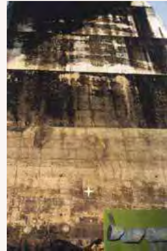
Fig. 5 – Vue de la pile.
