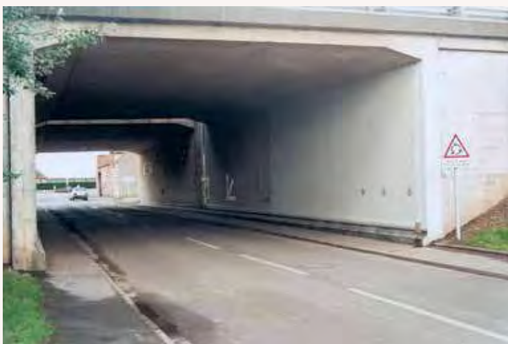
Exemple d'ouvrage évoluant peu et traité par un revêtement.
