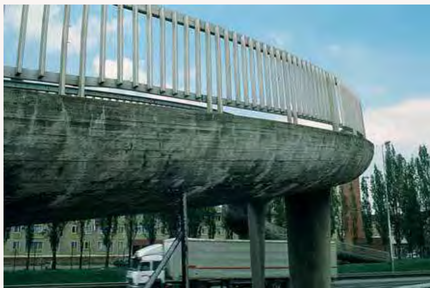
Fig. 12 – Vue générale de la passerelle
