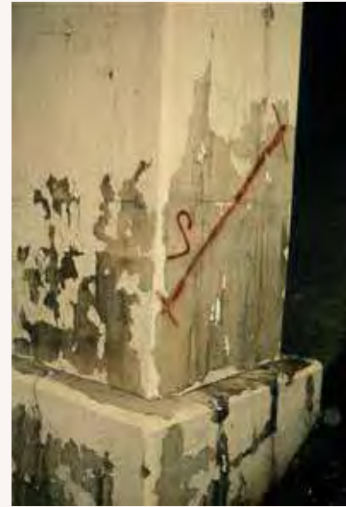
Fig. 5 – Fissuration d’une pile de pont revêtue d’une peinture et décollement de la peinture.
