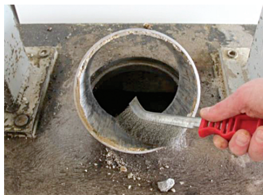
Figure 14 Nettoyage des moules à l'aide d'une brosse métallique, si nécessaire
