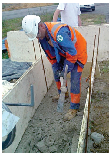
Figure 2 Piochage sur des tranchées, les panneaux de polystyrène latéraux permettant de ne pas perdre de matière par projection lors de l'impact de la pioche
