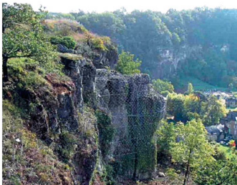
Figure Cas1.7 Dispositifs de protection mis en place dans le paysage
