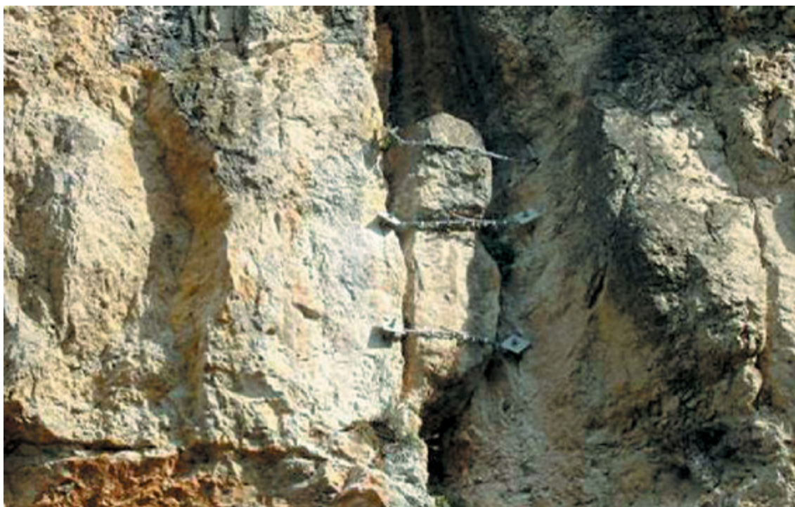
Figure SC2.1 Ancrage d'emballotement à Rocamadour (Lot)
