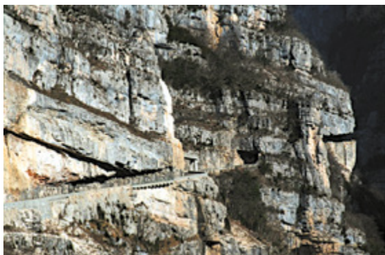
Figure Cas10.3 Éboulement 2004 à gauche, zone étudiée à droite
