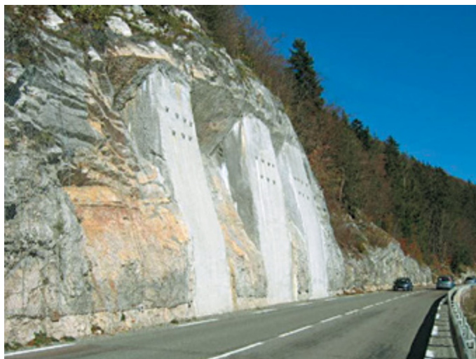
Figure SC1.6 Butons bétonnés dans les Alpes
