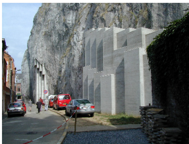
Figure SC1.7 Butons bétonnés avec traitement « architectural » à Dinant (Belgique)
