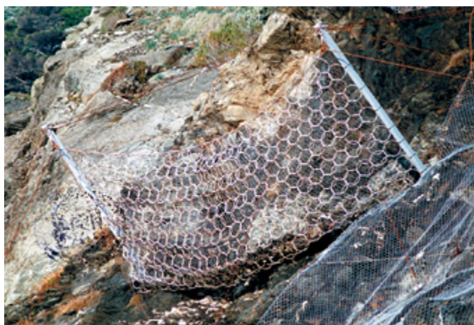
Figure EC2.1 Écran pare-blocs constitué d'un filet à anneaux
