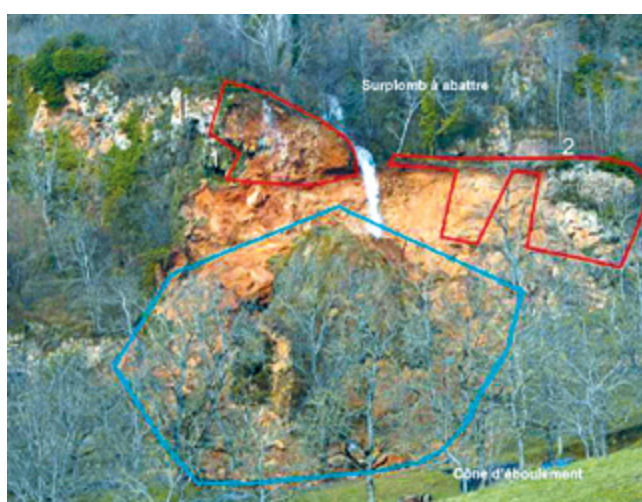
Figure Cas9.3 Vue générale et zones à purger en surplomb
