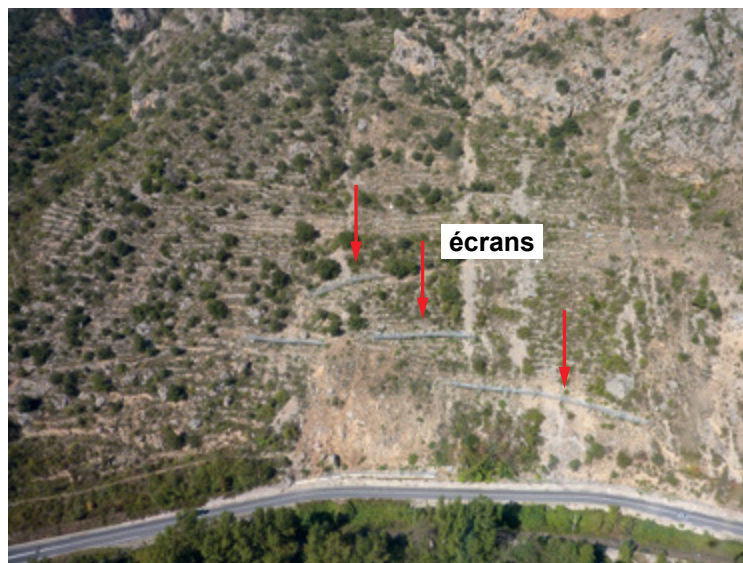
Figure Cas6.5 Vue aérienne des travaux finis : les écrans sont disposés en quinconce pour rappeler le rythme des cultures en terrasses
