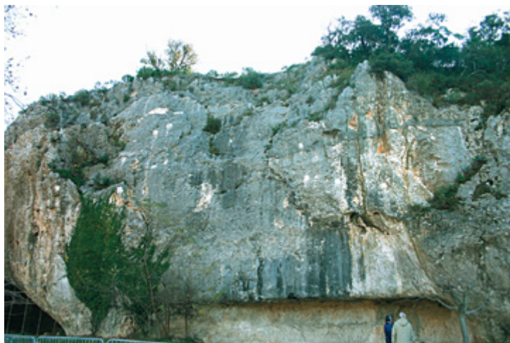
Figure SC2.4 Ancrages avec engravures limitant l'effet visuel – Pont du Gard (Gard)
