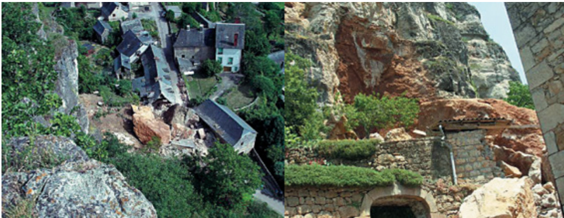
Figure Cas1.2 Éboulement du 23 juin 2005
