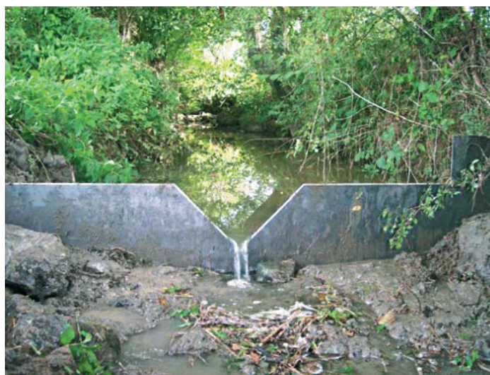
Figure Cas6.1 Seuil pour la mesure du débit du cours d'eau en aval du site expérimental.
