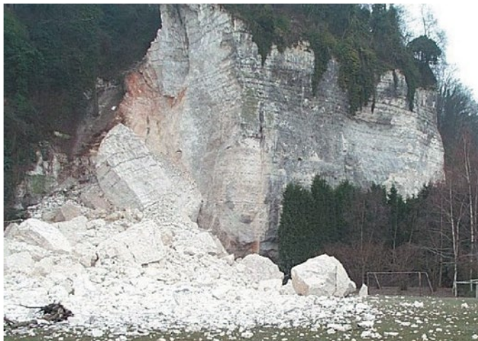
Figure 9 Basculement vers le vide d'une colonne de craie à Canteleu (Seine-Maritime)
