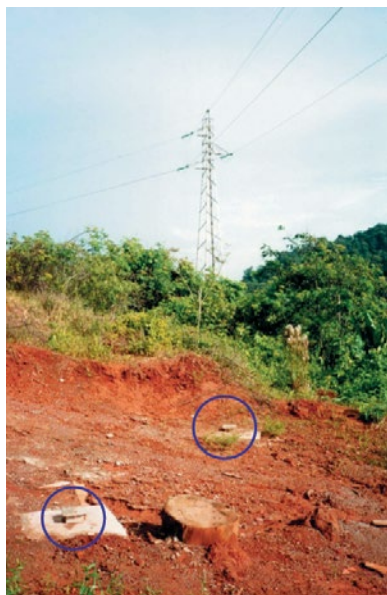
Figure Cas5.1 Têtes d'un tube inclinométrique et d'un tube piézométrique (cerclées en bleu)
