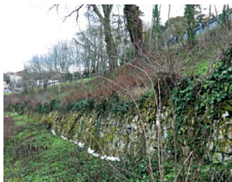
Figure Cas1.2 Mur de soutènement, février 2012
