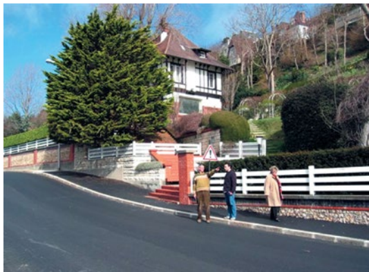
Figure Cas4.1 Rue et escalier affectés par le glissement de terrain
